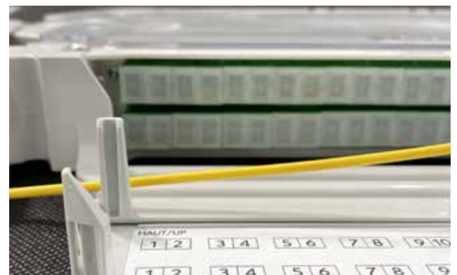
2 Insérer le cordon dans la goulotte et le faire cheminer côté axe de rotation du module
