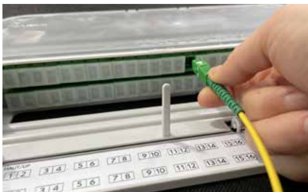
1 Ouvrir le volet de la goulotte et connecter la fiche
