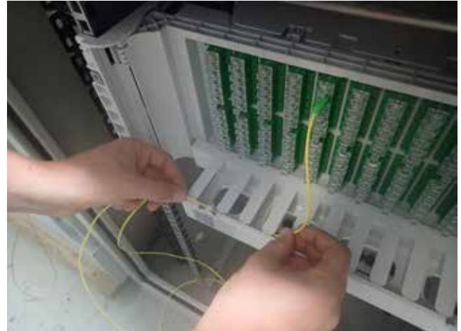
2 Insérer le cordon dans la goulotte Insert the patchcord in the cableway
