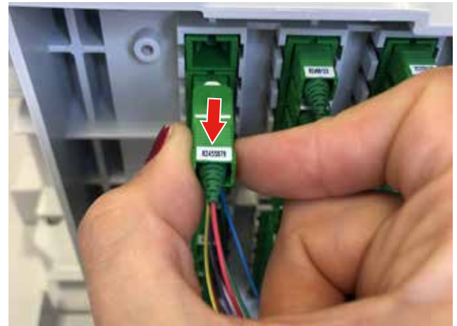
2 Déconnecter le pigtail et le cordon Disconnect the pigtail and the patchcord
