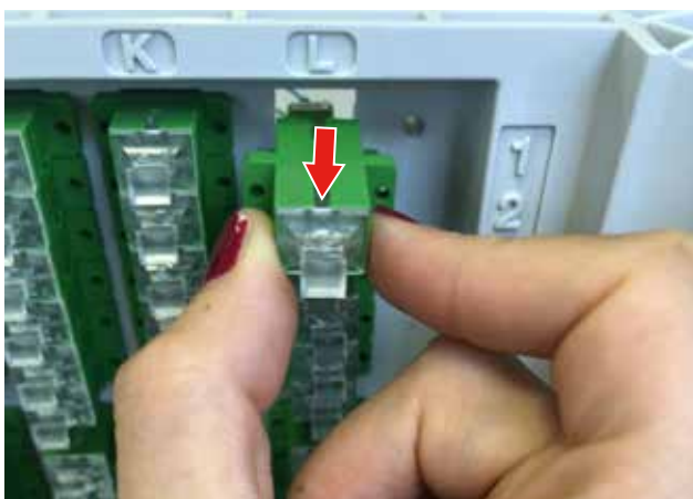
4 Clipper le nouveau raccord par l'avant Clip the new adaptor from the front
