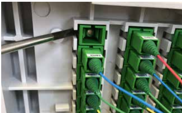
3 Déclipper l'ancien raccord par l'arrière Unclip the old adaptor from behind
