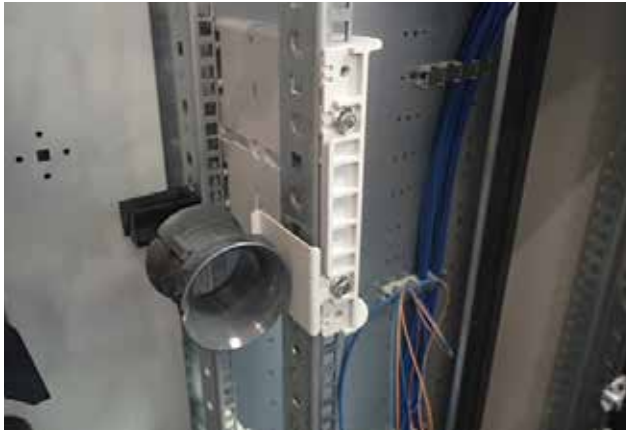
2 Montage du kit bobine (d/f + e) Mounting spool kit (d/f + e)
