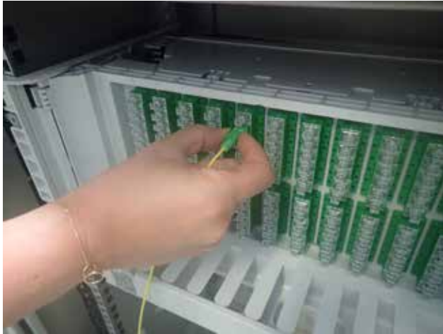
1 Ouvrir le volet de la goulotte et connecter la fiche Open the shutter of the cableway and connect the patchcord
